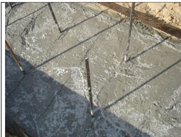
А. Трещины формовочные
